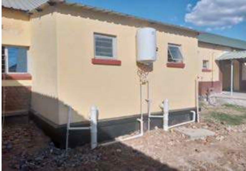
Aanbouw aan de afdeling Kizito, douche en toiletten voor staf
