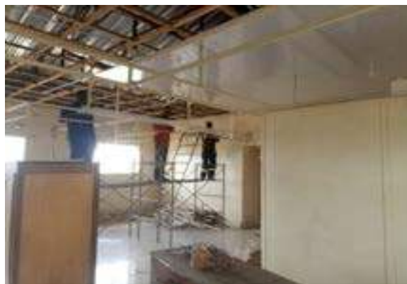
Installatie van het nieuwe plafond
